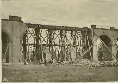
Abb. 20. Eisenbahn-Viaduct der Nordbahn bei Jessernik nach der am 14. Juli 1866 erfolgten Sprengung, mit dem von den preussischen Truppen bergestellten Provisorium. [Nach einer Photographie aus dem histor. Museum der k. k. Staatsbahnen.]
